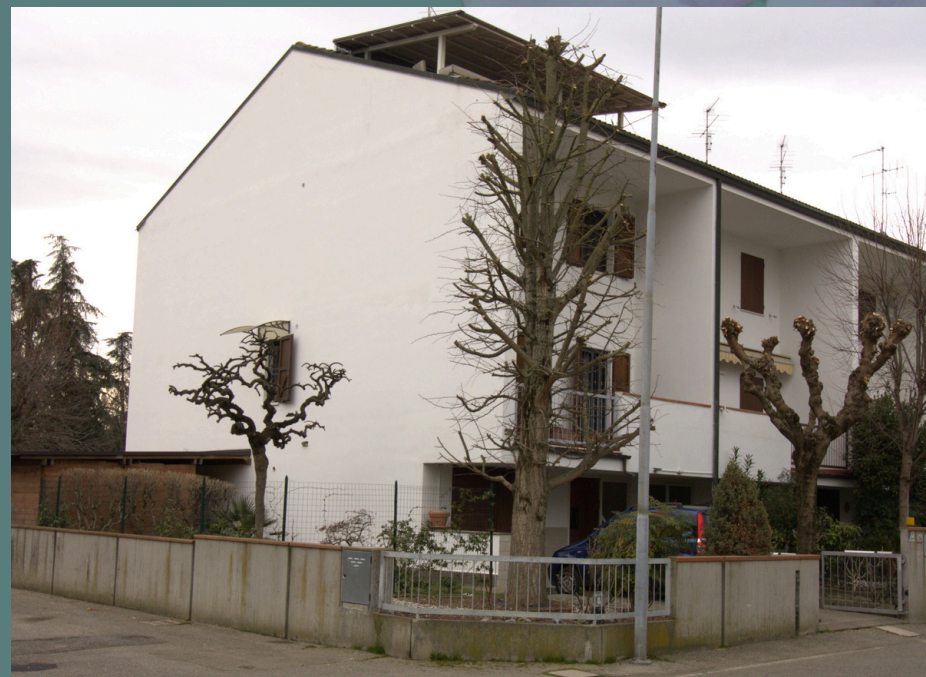
4 - Veduta esterna - Nord-Ovest
