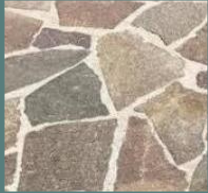
Pavimentazione in porfido
