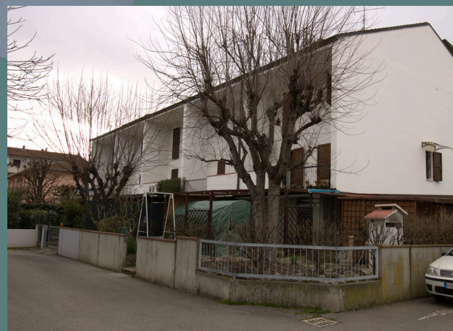
5 - Veduta esterna - Nord-Est
